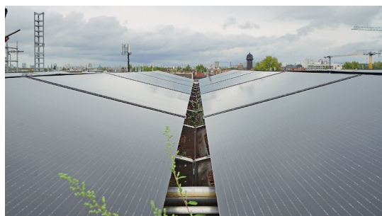
Die PVT-Anlage auf dem Dach des Dockyard vereint Photovoltaik und Solarthermie und ist aktuell die größte Deutschlands.
