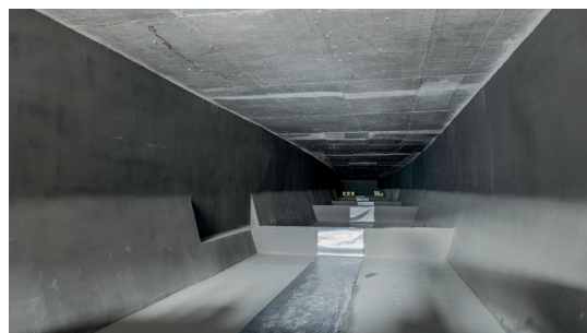
Der Eisspeicher mit 1.500 m 3 Fassungsvermögen als Saisonspeicher
