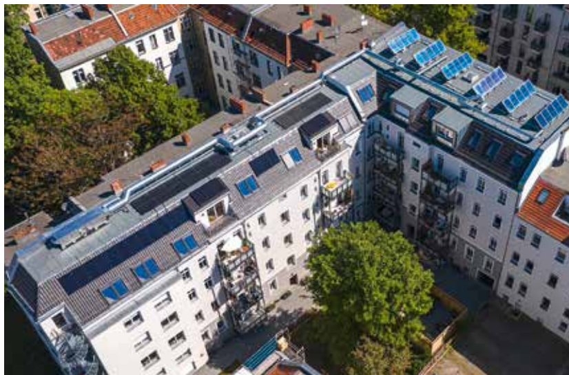
⑤ Sanierung einer Blockrandbebauung mit Wärmepumpentechnologie (Architekt: Taco Holthuisen, eZeit Ingenieure GmbH)
